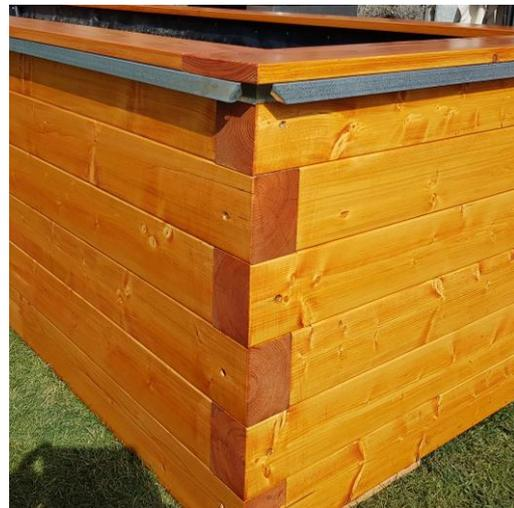
Schrauben Sie die weiteren Reihen zusammen und verschrauben Sie sie mit der jeweils darunterliegenden.
