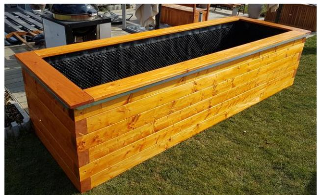
Danach legen Sie unten das Wühlmausnetz und befestigen Sie es mit ein paar Nägeln. Nageln Sie dann die Noppenfolie mit den Nägeln fest an.
